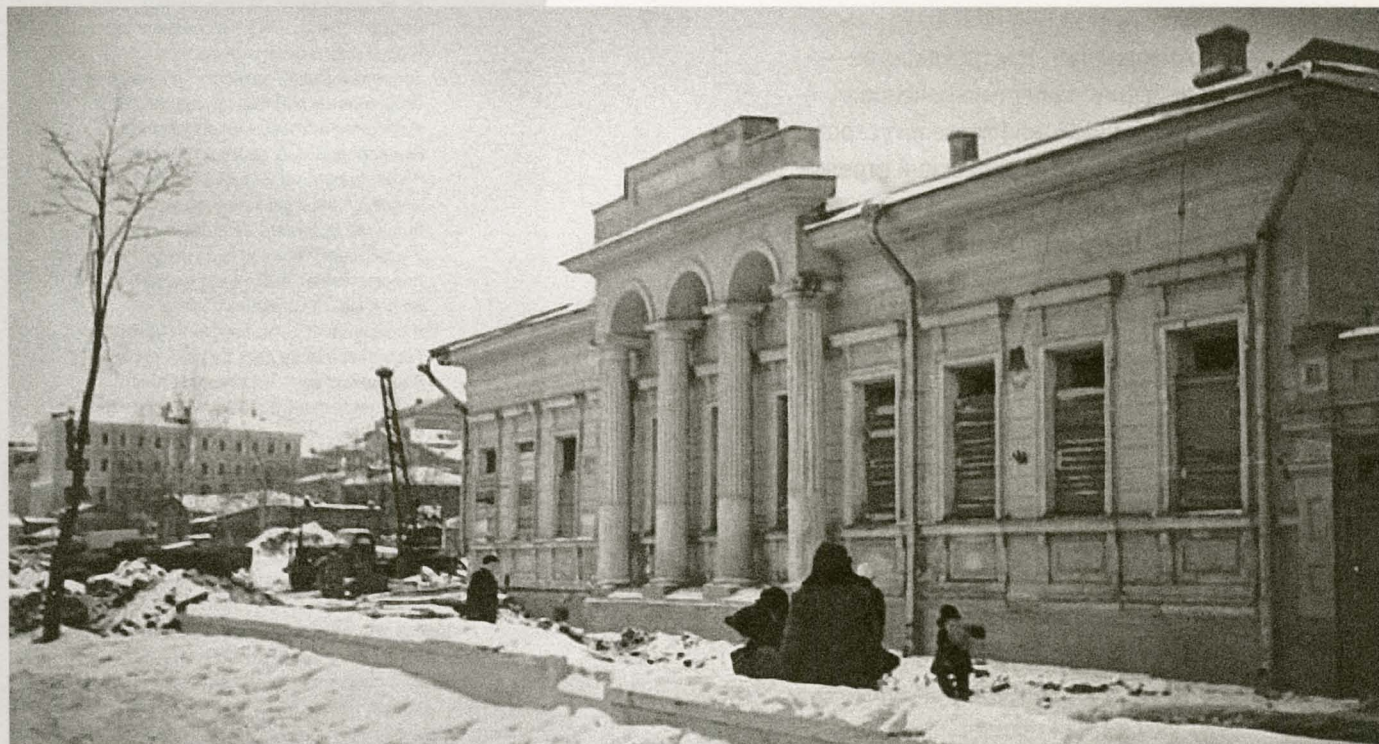
Москва. Собачья площадка. Строительство проспекта Калинина. Фото Г. Шмерлинга
